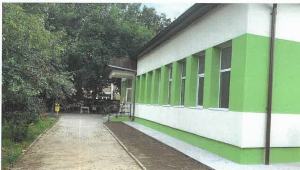
Reabilitarea termică a cantinei Liceului Teoretic „IRIS”
