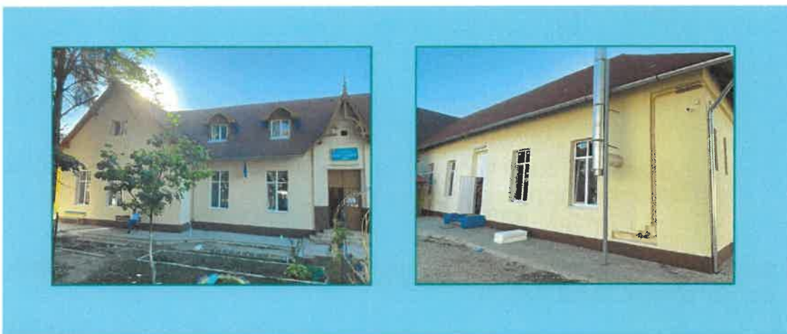
Izolare termică Centrul de Plasament Lugoj
