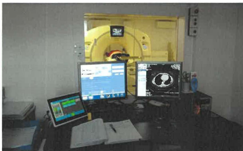
Computer tomograf CT mobil (instalat în container)
